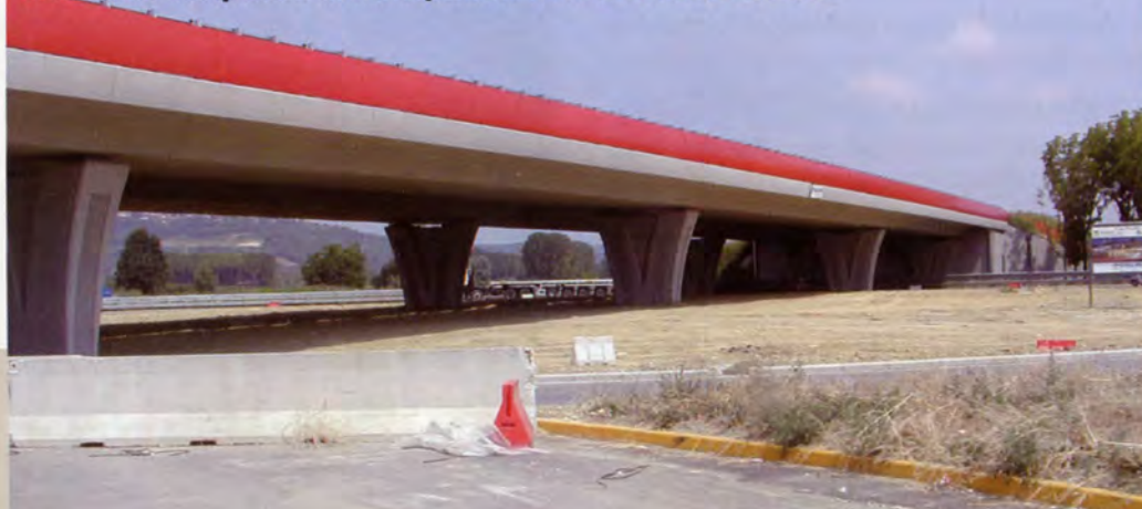
3. Viadotto completato in corrispondenza dello svincolo di Neive
